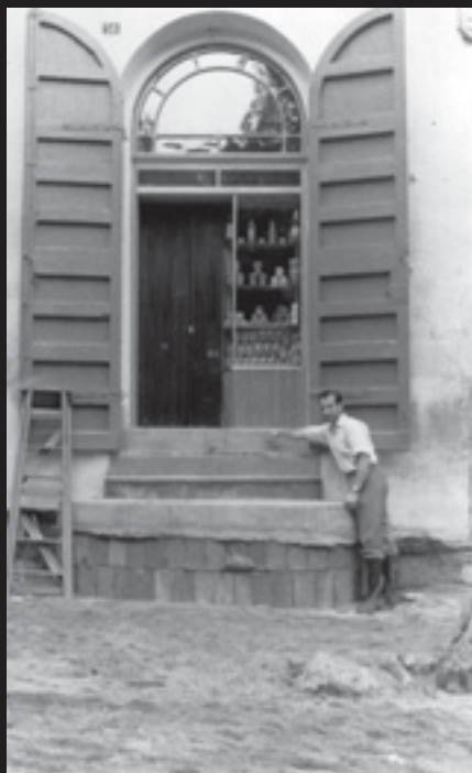
LA BOTIGA DE COMESTIBLES MARTÍ, A L'ACTUAL POLICIA LOCAL L'ANY 1962. LA RIERADA D'AQUELL ANY VA FER BAIXAR EL NIVELL DEL TERRA DE LA RIERA PROP D'UN METRE.
