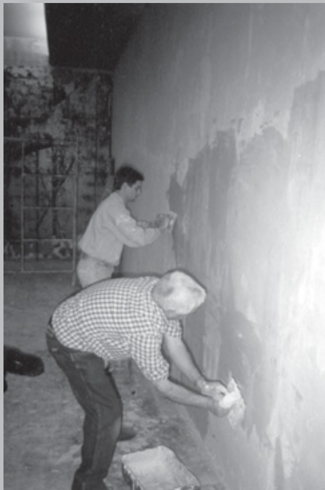
VOLUNTARIS EXECUTANT TASQUES DE RESTAURACIÓ DE LA SALA D'ACTES DE LA SOCIETAT
