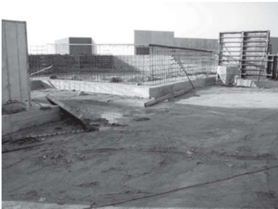
IMATGE DE LES OBRES DE LA NOVA DEIXALLERIA MANCOMUNADA.
